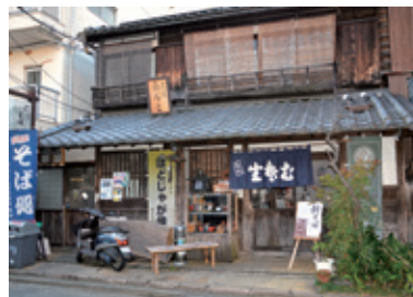
① 深川江戸資料館の船宿を手掛けた棟梁による桑名屋。釘を1本も使っていない
