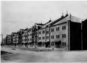
第一號煉瓦造倉庫の前面(赤レンガ倉庫) 1915年『横浜税関新港設備概要』より
