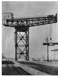
五十噸定置起重機(ハンマーヘッドクレーン)1915年『横浜税関新港設備概要』より
