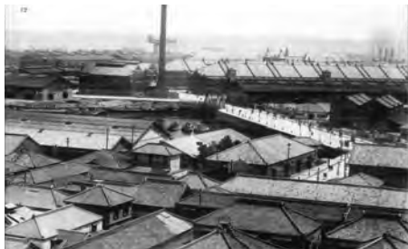
港内発電町、新港橋、岸壁 大正6年「横浜全景絵葉書」より奥に「ハンマーヘッド」が見える
